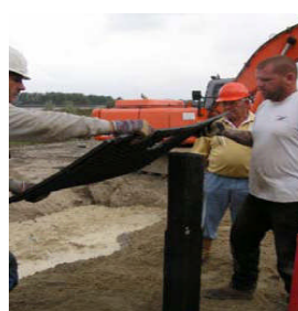
PVC vloerplaat over PE-paal plaatsen
