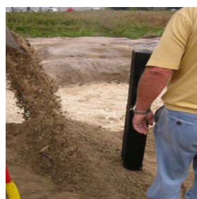
Met zand aanvullen tot maaiveldhoogte
